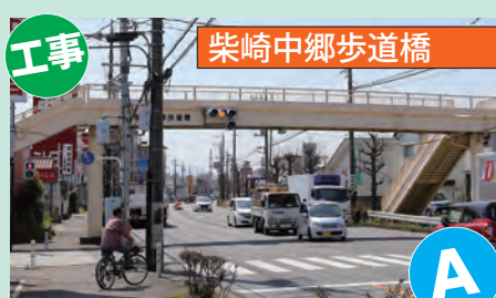
橋りょう補修塗替え塗装をします (深谷東松山線)
