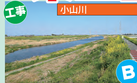
河川の整備・河道掘削を行います
