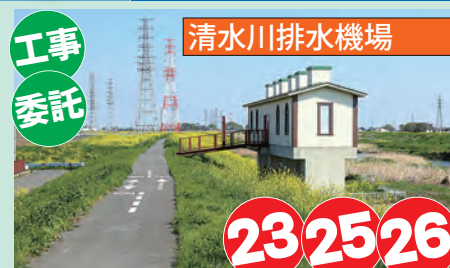
排水機場等の維持や修繕を行います (清水川排水機場)
