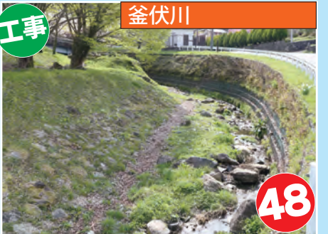
護岸を修繕します
