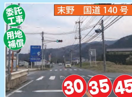
安全に通行できる道路を作ります (国道 140 号)
