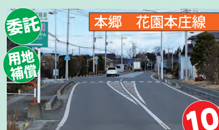
道路を拡幅整備します
