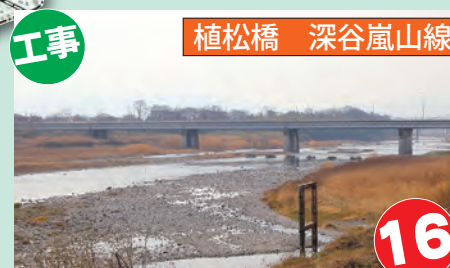
橋りょうを (伸縮装置) 修繕します
