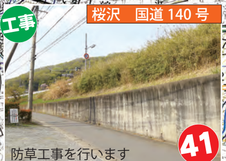
防草工事を行います
