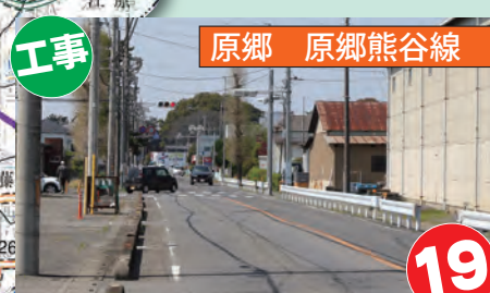
傷んだ道路を修繕します
