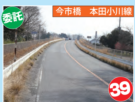
傷んだ橋りょうを修繕します
