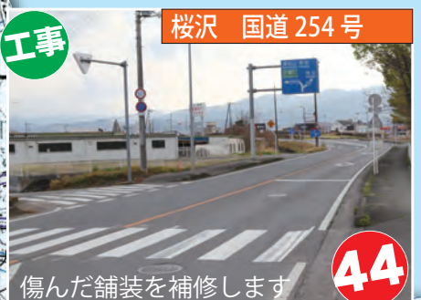
傷んだ舗装を補修します
