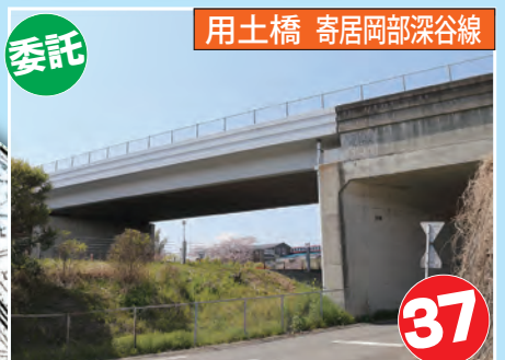
橋りょうを修繕します
