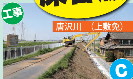
堤防を強くする工事をします (唐沢川)
