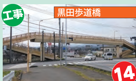
橋りょうを修繕 (塗装) をします
