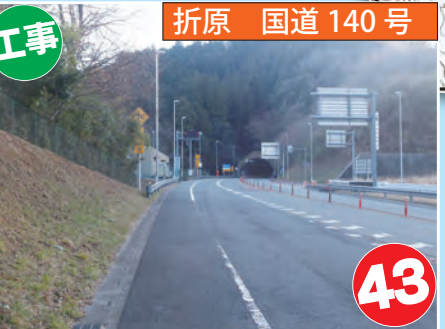
傷んだ舗装を修繕します (国道 140 号)
