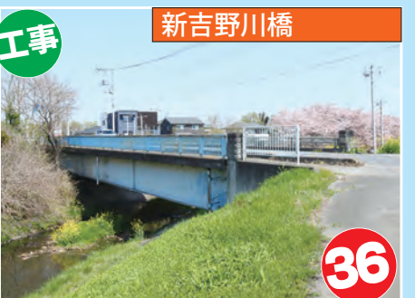
落橋防止のため橋りょうを補修します (菅谷寄居線)
