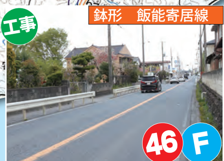
傷んだ舗装の修繕と、鉢形歩道橋の橋りょう塗り替えをします
