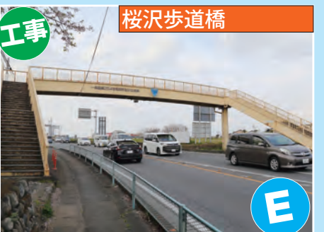
橋りょうの修繕 (塗り替え塗装) をします (国道 254 号)
