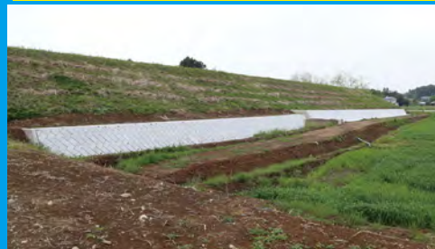
耐震補強工事が済んだ本堤(下流部)
