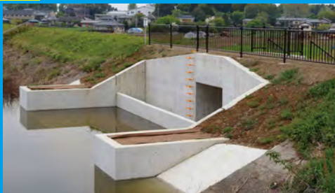
改修された洪水吐
