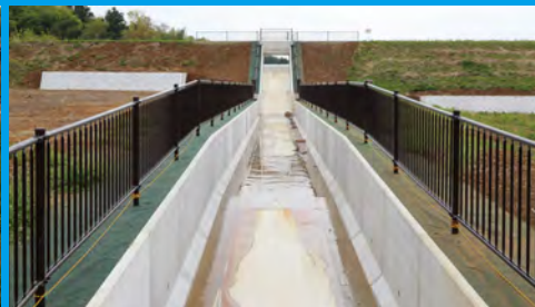
改修された洪水吐と下流水路
