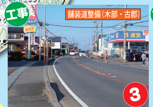
傷んだ舗装を修繕します（本庄寄居線）
