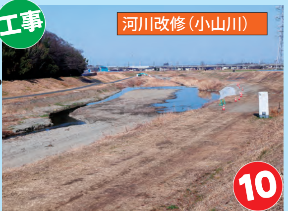
河川管理施設の修繕を行います
