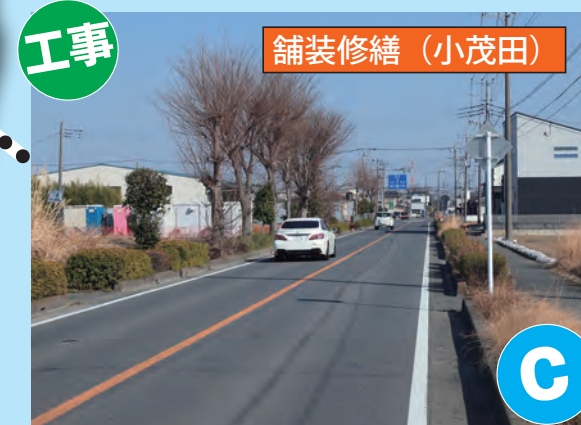
傷んだ舗装を修繕します（蛭川普済寺線）
