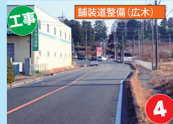
傷んだ舗装を修繕します（国道254号）
