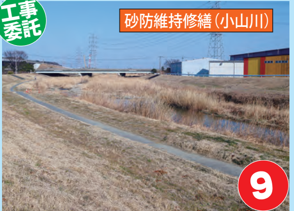
護岸の修繕などを行います
