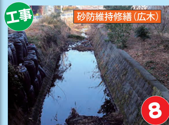
護岸を修繕します（粉木川）
