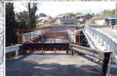
旧橋撤去(関山川)
