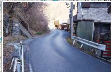
道路改築(広木折原線)
