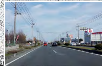
舗装道整備(140号線)
