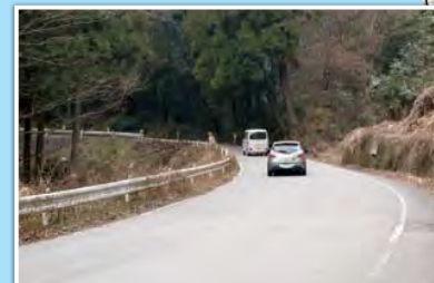
道路改築(坂本寄居線)
