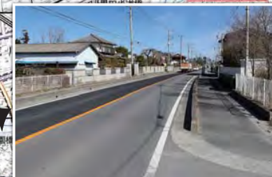
舗装道整備(熊谷寄居線)
