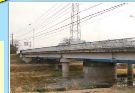
橋りょう修繕 (見馴川橋)
