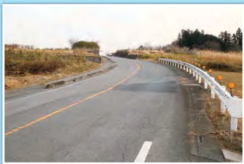
舗装道整備 (広木折原線)
