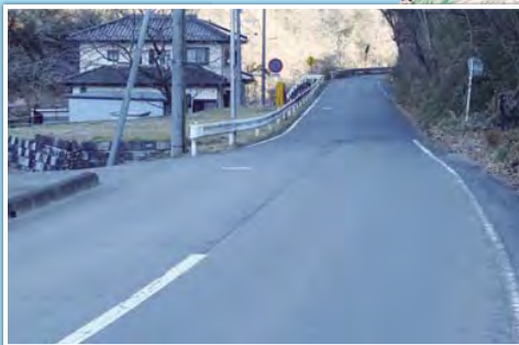
道路改築 (広木折原線)
